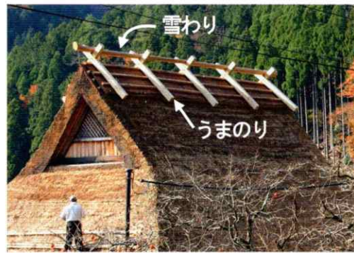
ただいま、屋根の葺き替え中
