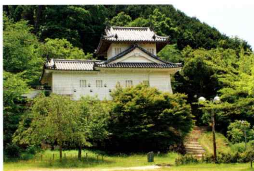
昭和43年に復元された西隅櫓
